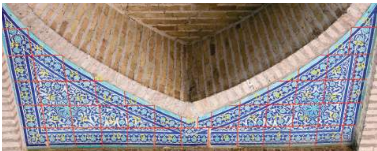
Ил. 23. Хива, медресе Мухаммеда Амин-хана (1851-1855), пазух над аркой (фото: Б. О'Кейн). Красные линии добавлены, чтобы показать плитки.
