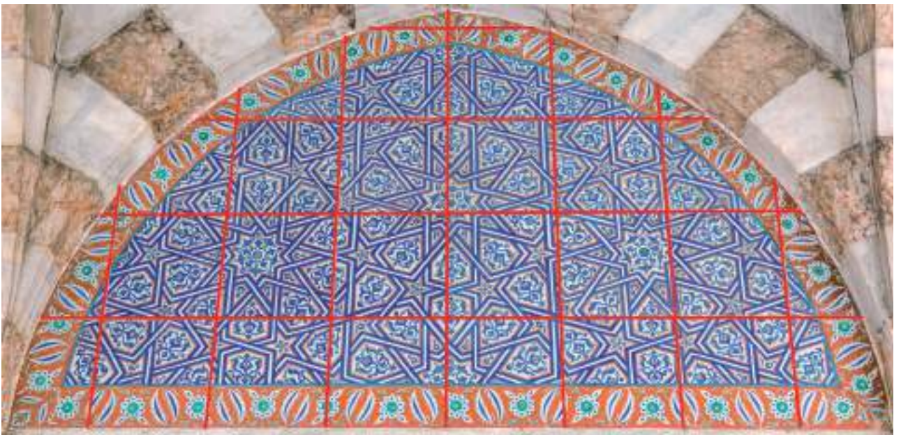
Ил. 26. Стамбул, собор Св. Софии, мавзолей султана Селима II (1577 г.), тимпан над входом (фото: Б. О'Кейн). Красные линии добавлены, чтобы показать плитки.
